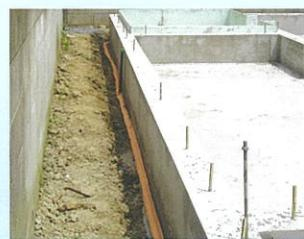
基礎に沿って、基礎の下端付近にパイプを設置します。
