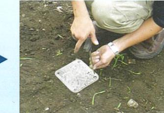
注入口ボックスのフタを閉めて完了です(専用のドライバーを使います)。
