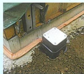
注入口を組み立てて、注入口ボックスを仮設置します。
