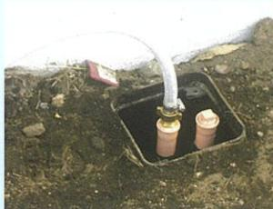
地表面に設置された注入口から、シロアリ防除剤を注入します。
