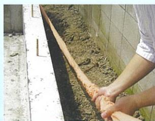
組み立てたパイプに、専用のパイプカバーを被せます。
