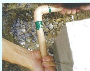
基礎の形状に合わせて、パイプを組み立てていきます（専用の接着剤を使います）。
