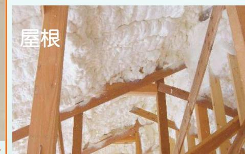
一般的な吹付けウレタンでは、屋根、天井は液垂れを起こし、施工が困難ですが、アイシネンなら場所を選ばず施工できます。
