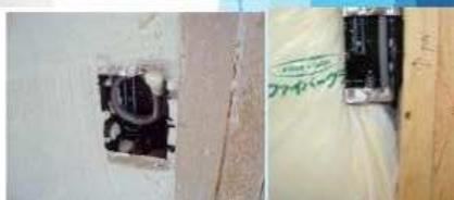
気密がとりにくい(コンセントBOX)の廻りも、アイシネンの100倍発泡でしっかりと充填し、漏気を防ぎます
