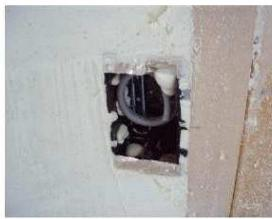
気密がとりにくい(コンセントBOX)の廻りも、アイシネンの100倍発泡でしっかりと充填し、漏気を防ぎます
